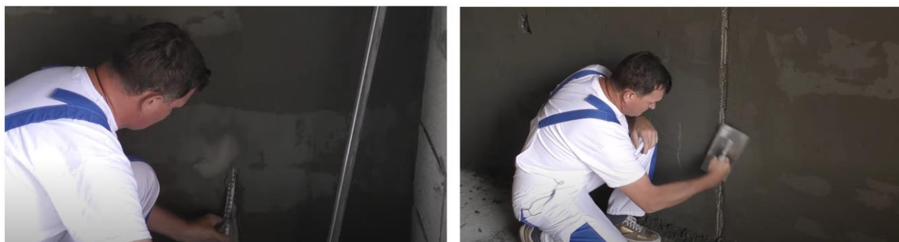
Рис. 25. Схема демонтажа маяков и заделки образовавшихся борозд
